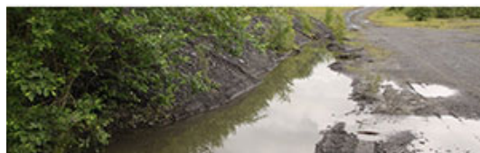
Figure 3: Canalisation par diguettes permettant de décanter l'eau d'un ruissellement à Lustin (Sagrex). Nouveau fossé collecteurs en bordures de pistes sur le site des Carrières du Hainaut
