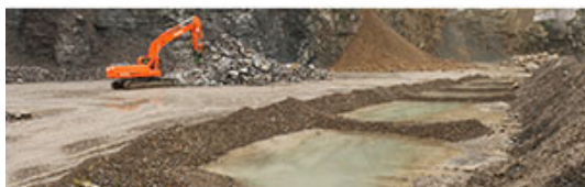
Figure 3: Canalisation par diguettes permettant de décanter l'eau d'un ruissellement à Lustin (Sagrex). Nouveau fossé collecteurs en bordures de pistes sur le site des Carrières du Hainaut
