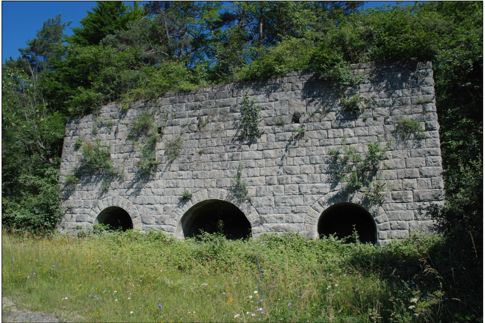
Anciens fours à Chaux (Wellin)
